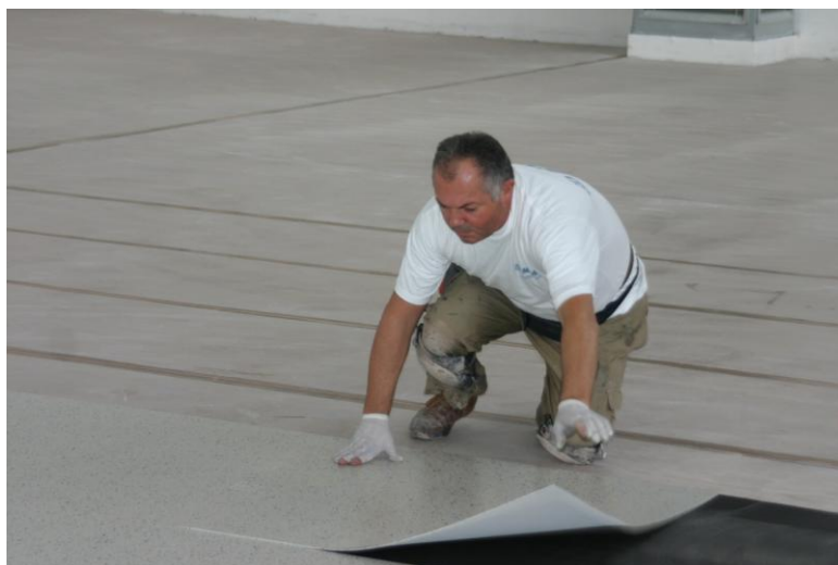
fig. 5 Posa di pavimento resiliente su adesivo conduttivo in ambiente ESD
