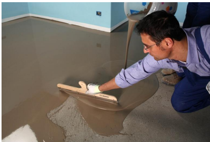
fig. 3 Lisciatura del piano di posa
