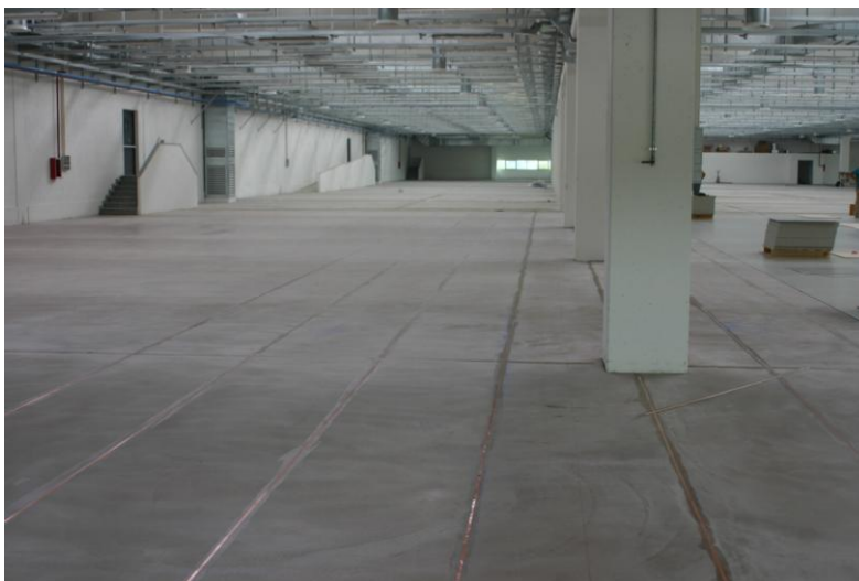
fig. 4 Superficie pronta alla posa del pavimento
