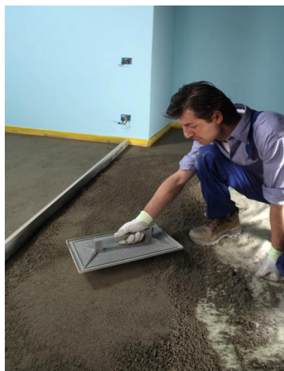
fig. 2 Compattazione e finitura
