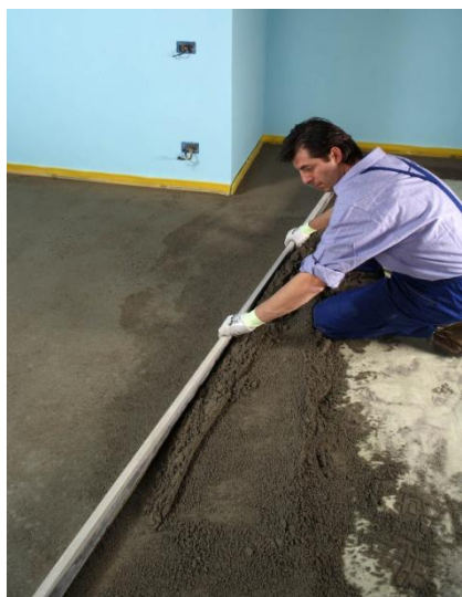
fig. 1 Stesura di massetto
